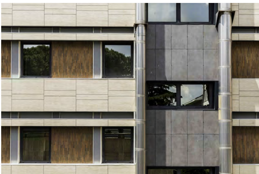
Particolare rivestimento facciata
